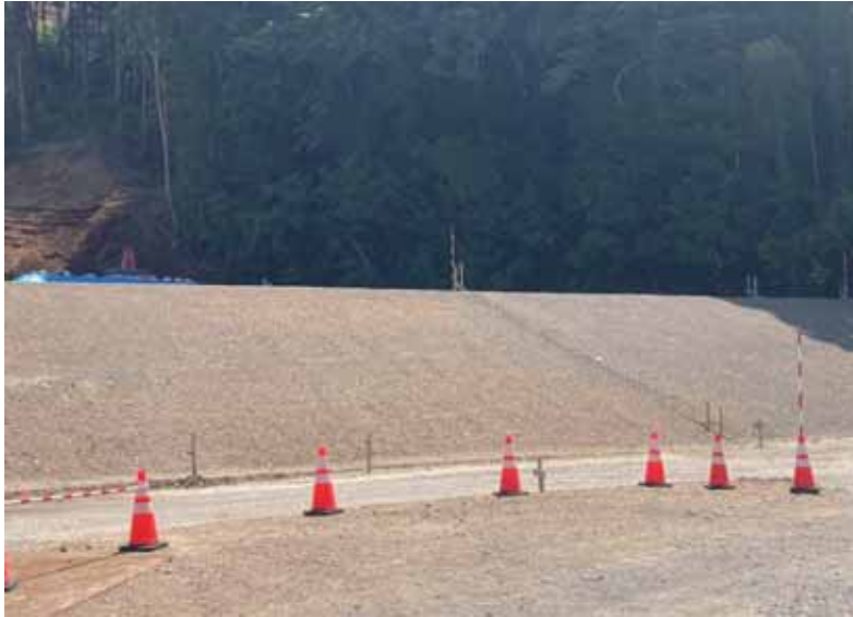
写真 3-1 適切な斜面・擁壁の角度等の維持
