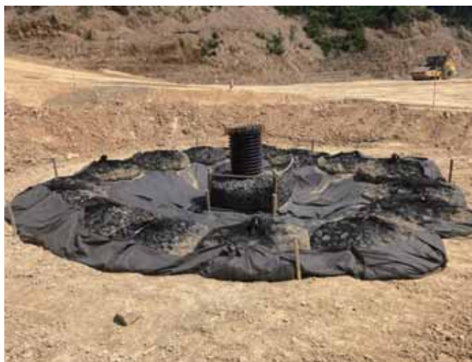
写真1-3 堅樋（仮設調整池③）
