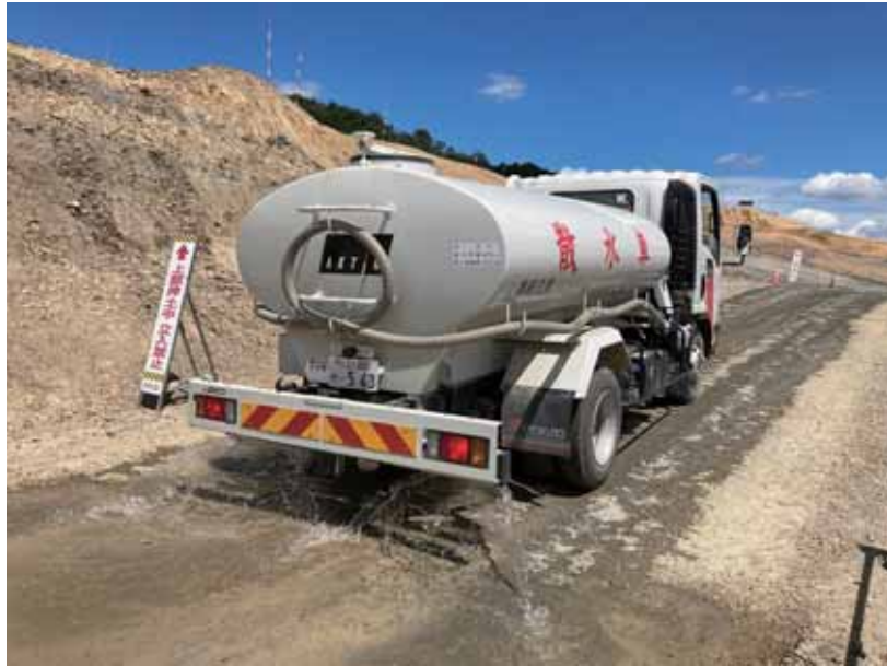
写真 5-1 工事現場内の散水の実施状況
