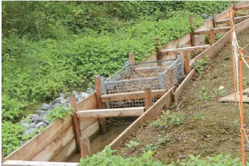
写真 4-2 伐採樹木の一部使用（濁水ろ過フィルターに利用）
