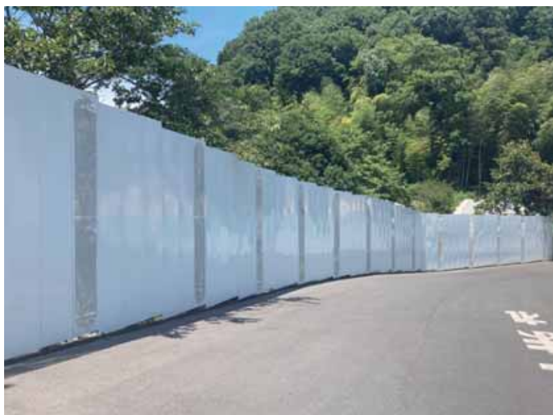
写真 6-5 仮囲いの設置
