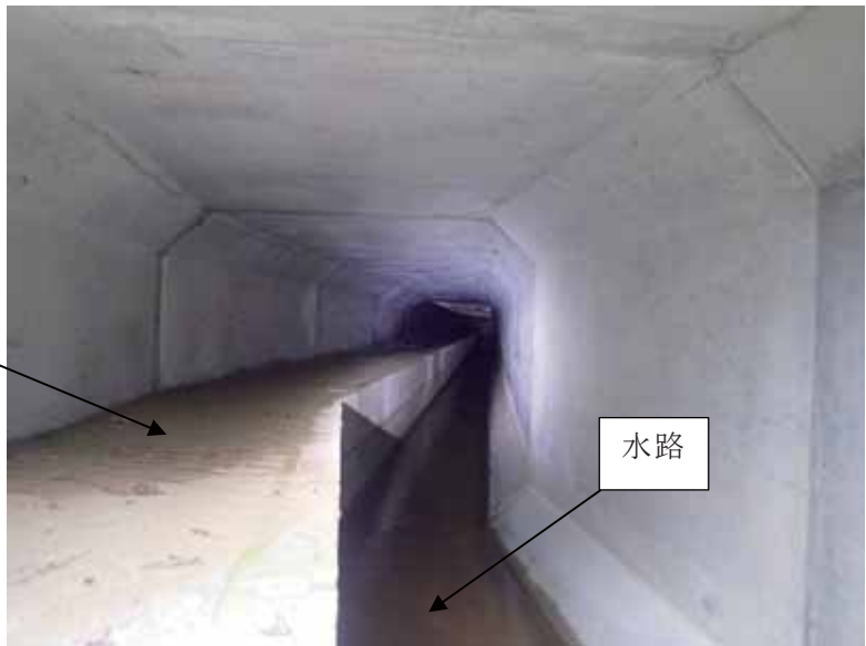
写真 7-17 水路の構造を工夫した動物の移動経路（動物通路）
