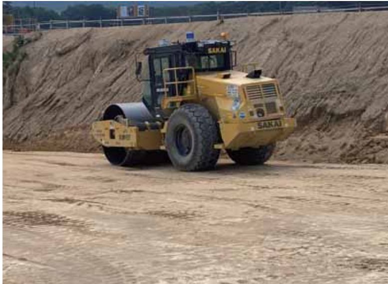
写真 3-4 造成法面の転圧
