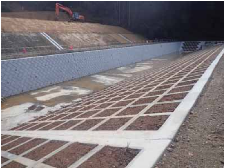
写真 7-18 植生ブロックにより自然環境に配慮した調整池護岸
