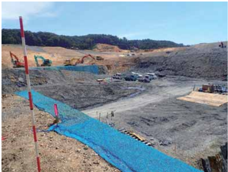
写真 7-19 池底に水や泥を溜め自然環境に配慮した調整池（施工中）
