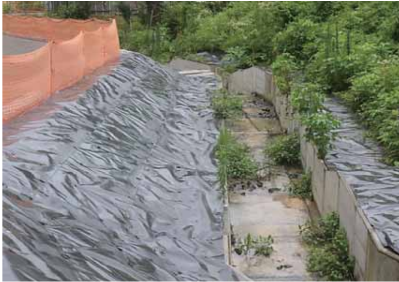
写真 2-1 工事用排水路の整備
