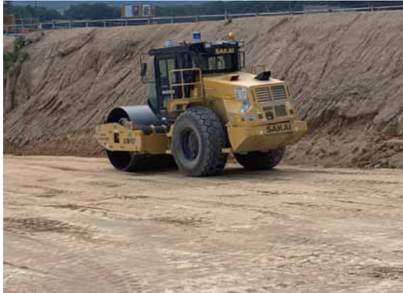
写真 1-6 造成箇所の転圧
