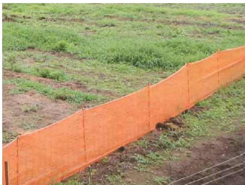
写真 1-5 土砂流出防止柵の設置
