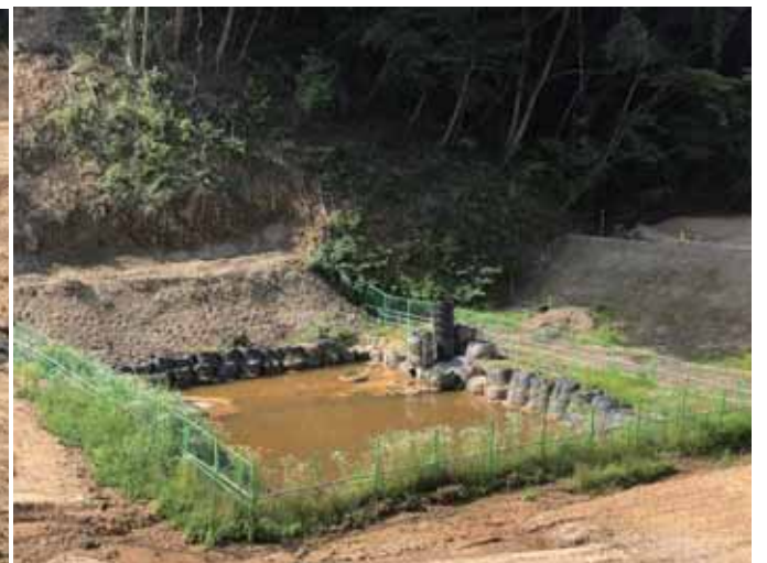
写真1-4 仮設沈砂池（仮設調整池③）
