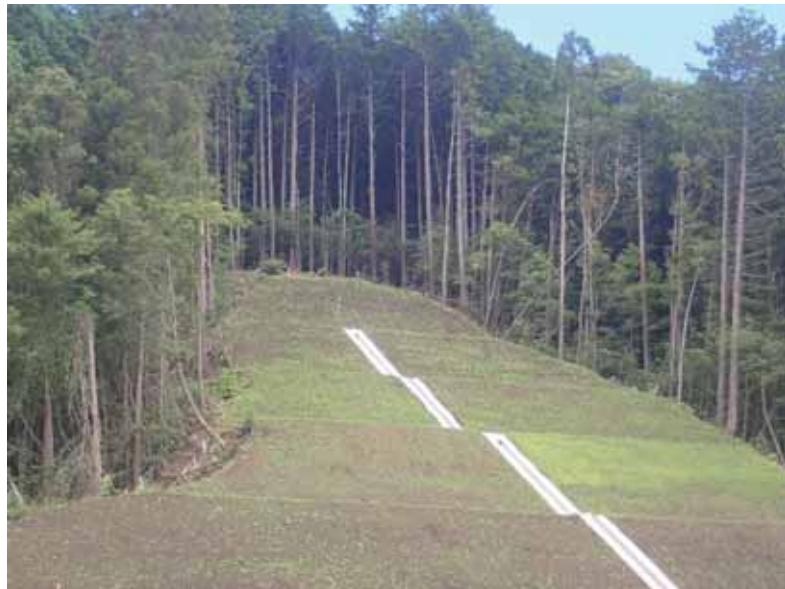
写真 7-15 切土法面の吹付緑化
