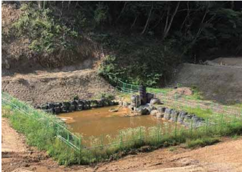
写真 2-2 仮設調整池(仮設沈砂池)の整備
