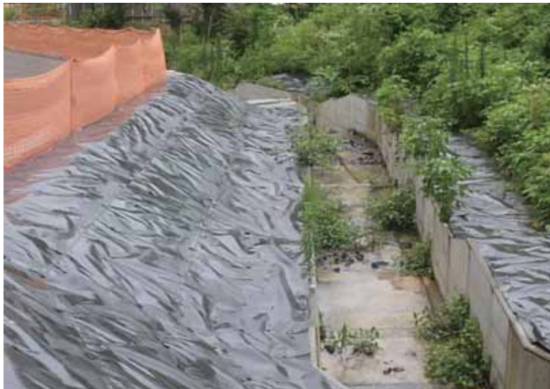
写真 3-5 工専用排水路の設置
