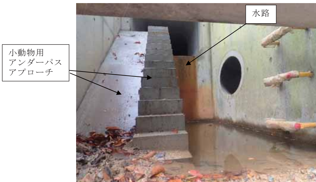
写真 7-16 水路の構造を工夫した動物の移動経路（出入口）
