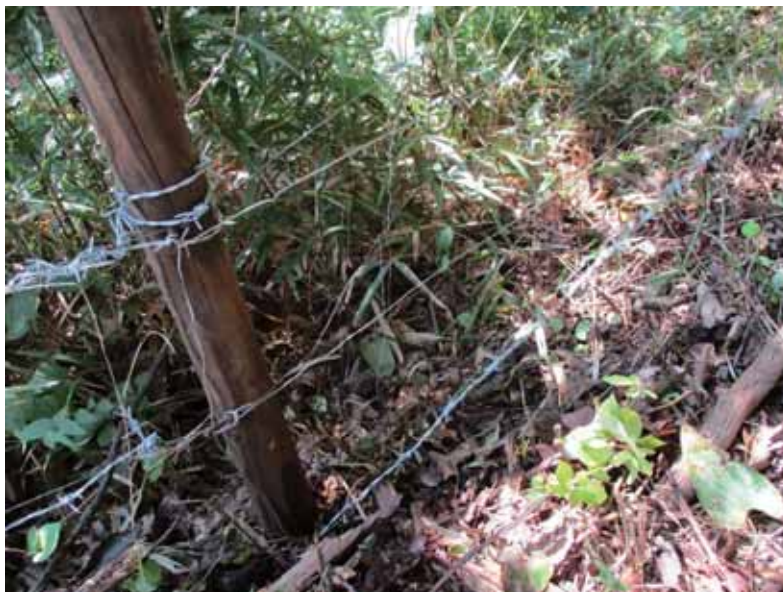
写真 7-8 獣害防止フェンスの管理状況（近景）
