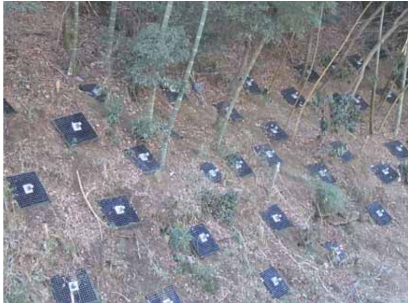
写真 2-4 グリーンパネル工法
