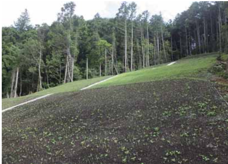
写真 1-7 造成法面の植栽の状況
