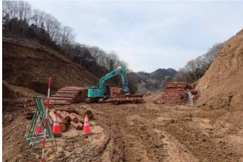
写真 7-2 計画地南側の中央部南側の工事作業状況
