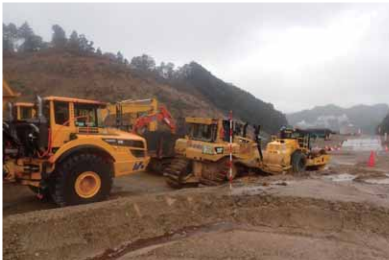
写真 8-6 工事区域内の建設機械等の保管状況
