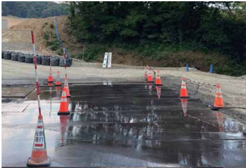
写真 5-2 鉄板敷設状況
