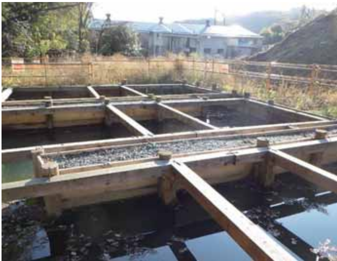
写真1-1 仮設沈砂池（仮設調整池①）
