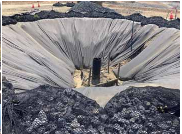
写真1-2 堅樋（仮設調整池②）
