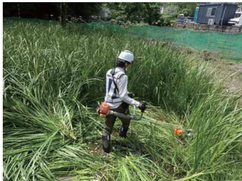
写真 7-4 整備中ビオトープの開放水面維持管理
