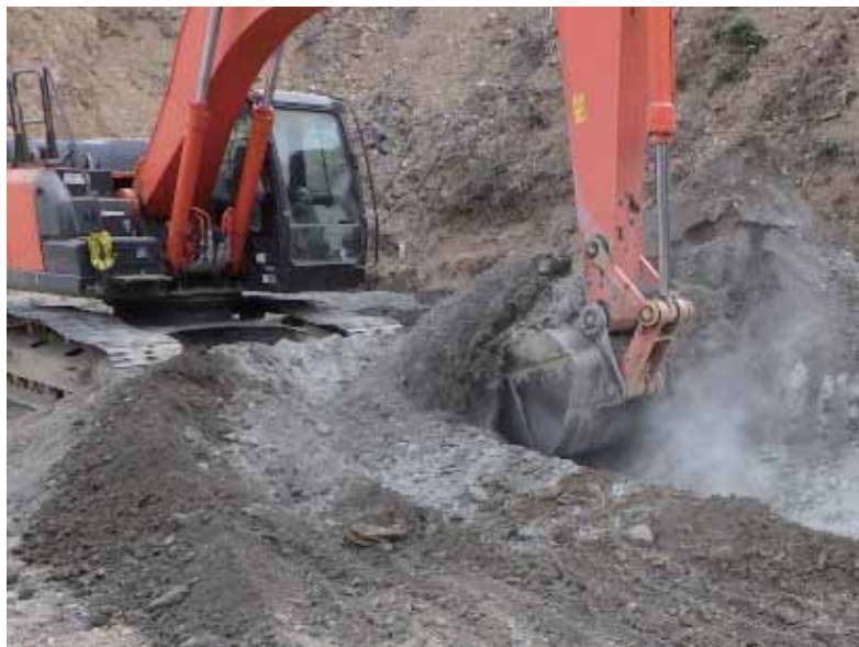
写真 3-3 盛土法面の地盤改良
