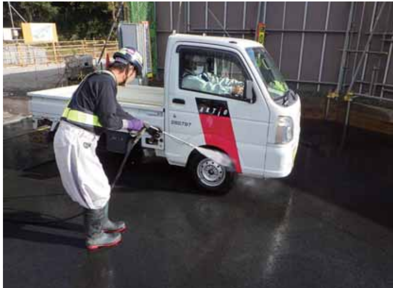
写真 5-7 車両のタイヤ洗浄
