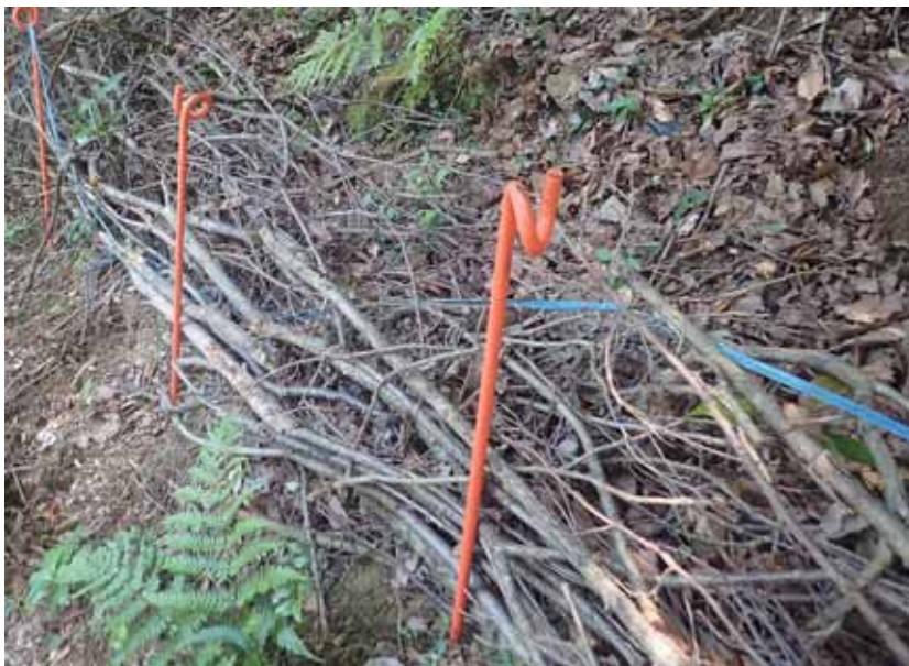
写真 4-3 伐採樹木の一部使用（しがら柵に利用）
