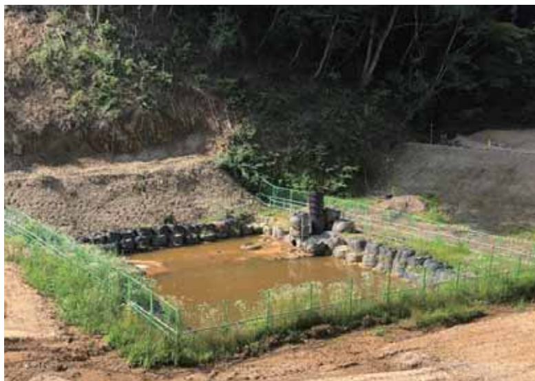
写真 3-6 仮設調整池(仮設沈砂池)の設置
