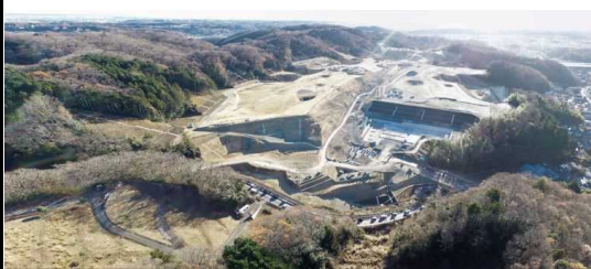
第一ゲートよりエリア1,2
