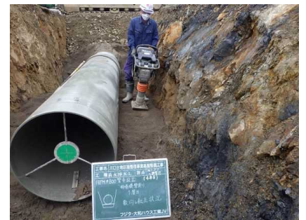
エリア1,2雨水排水工事
