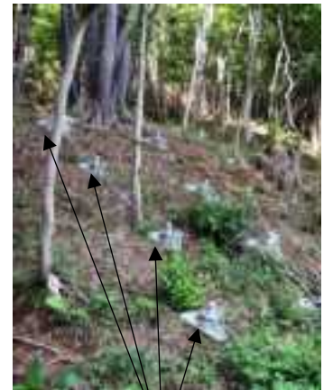
急傾斜地にアンカー等を直接設置することにより、斜面の崩壊を防止する。
