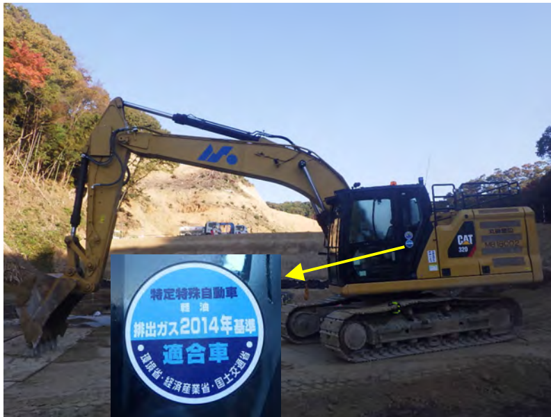
写真 5-4 排出ガス対策型の建設機械
