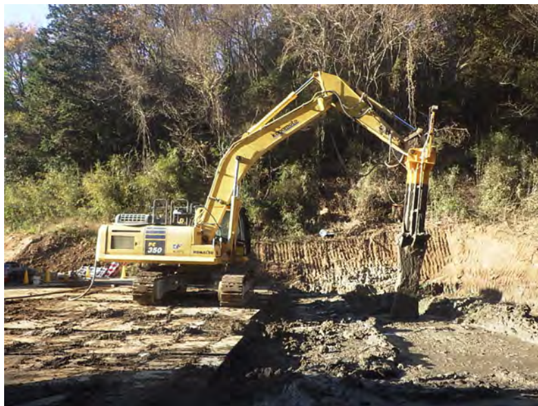
写真 3-3 盛土法面の地盤改良
