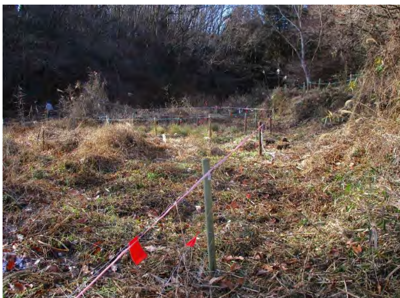
写真 7-8 獣害防止フェンスの設置状況（近景）
