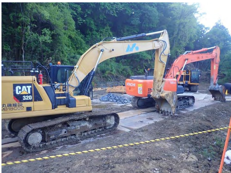
写真 8-6 工事区域内の建設機械等の保管状況
