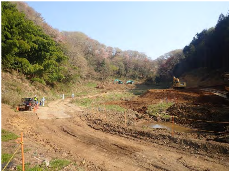
写真 7-2 計画地南側南端の工事作業状況
