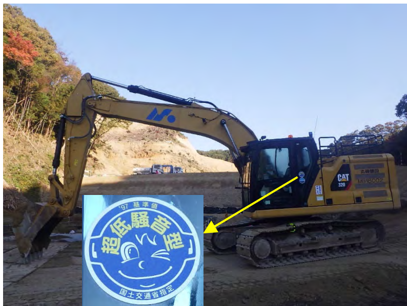
写真 6-1 低騒音型の建設機械
