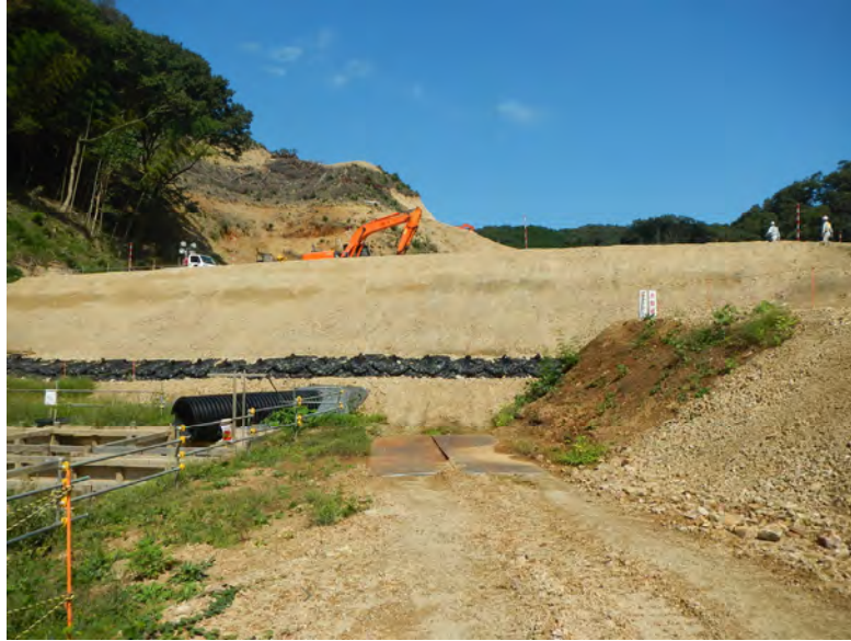
写真 3-1 適切な斜面・擁壁の角度等の維持
