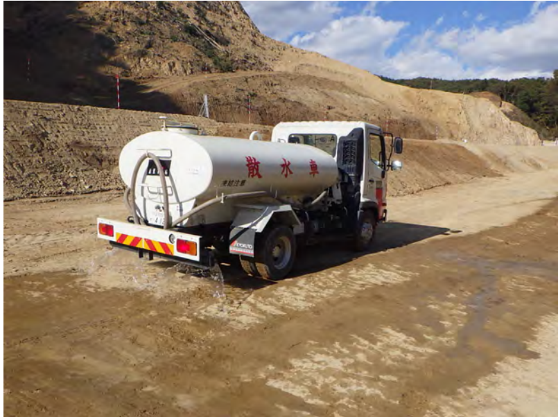
写真 5-1 工事現場内の散水の実施状況
