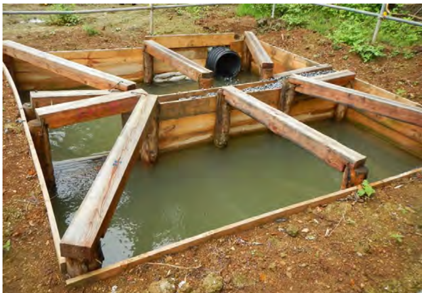
写真 2-2 仮設調整池(仮設沈砂池)の整備
