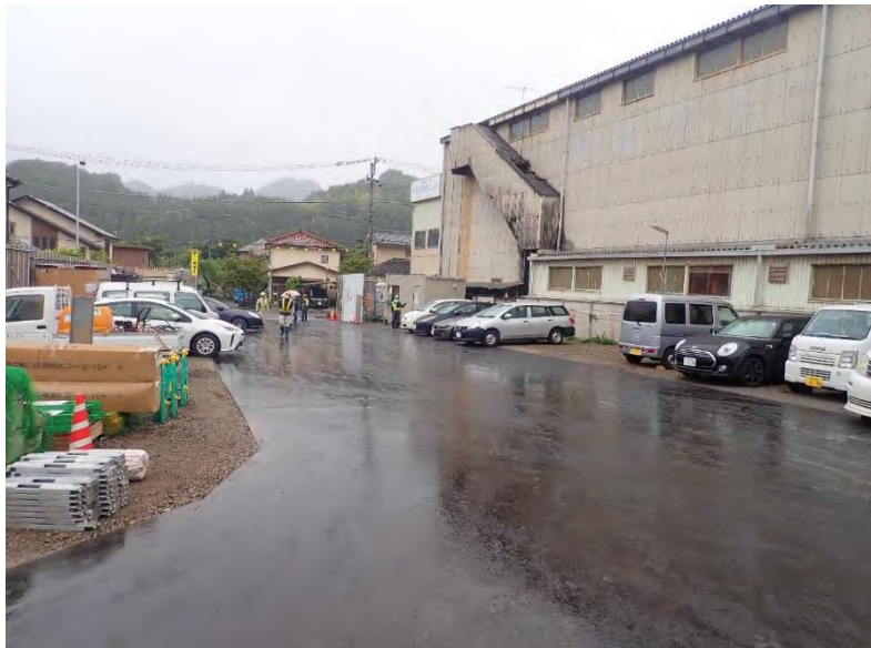
写真 8-5 工事区域外に整備した工事関係車両の駐車場
