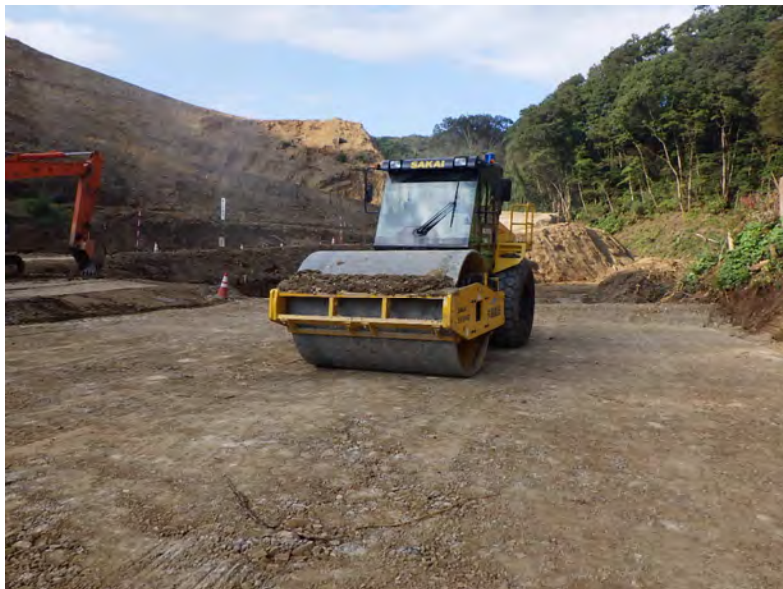
写真 1-4 造成箇所の転圧
