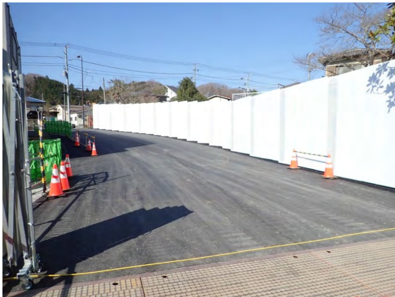
写真 6-5 仮囲いの設置
