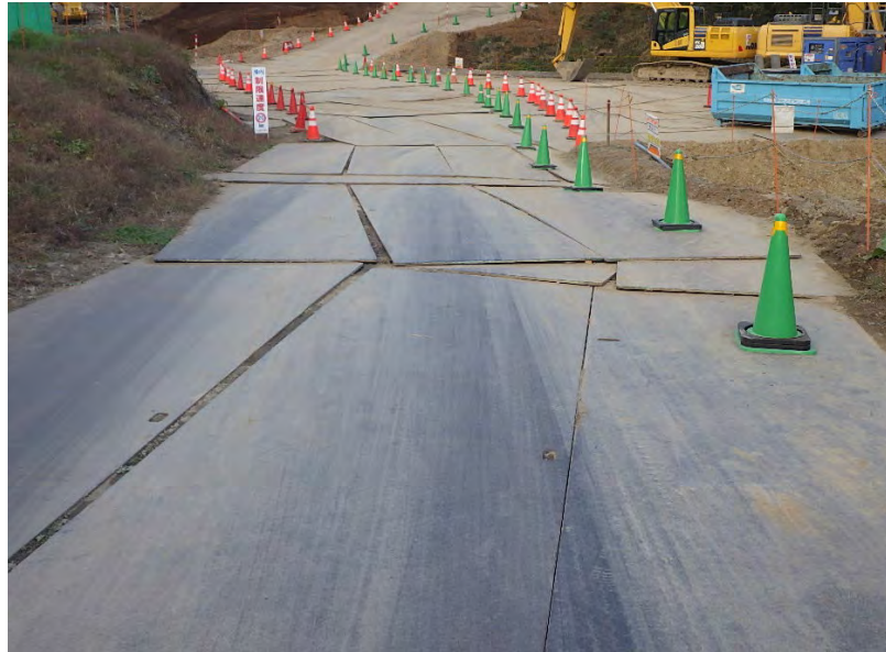
写真 5-2 鉄板敷設状況
