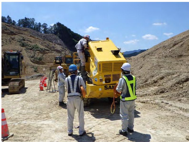
写真 6-2 建設機械の点検・整備
