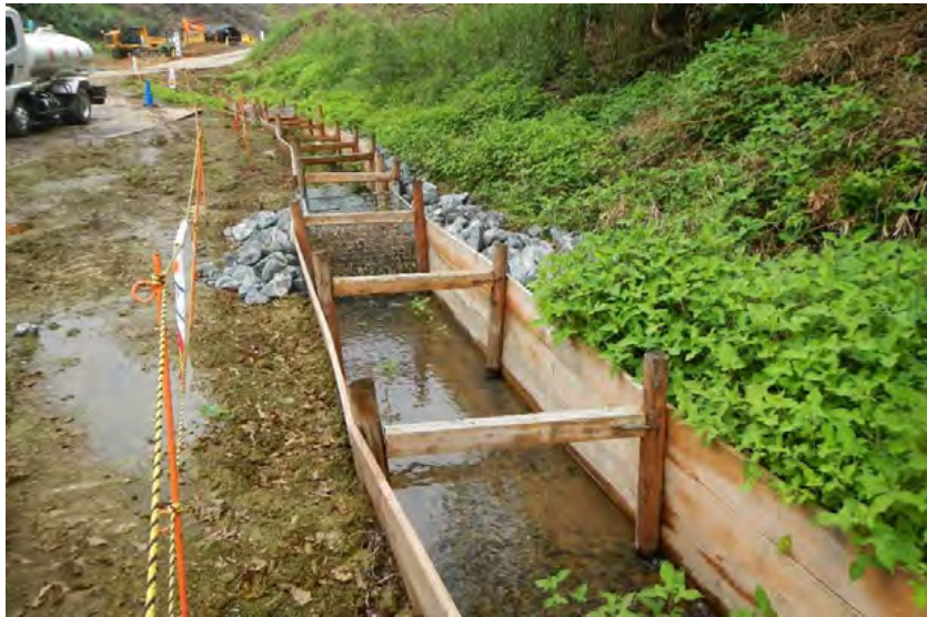
写真 2-1 工事用排水路の整備
