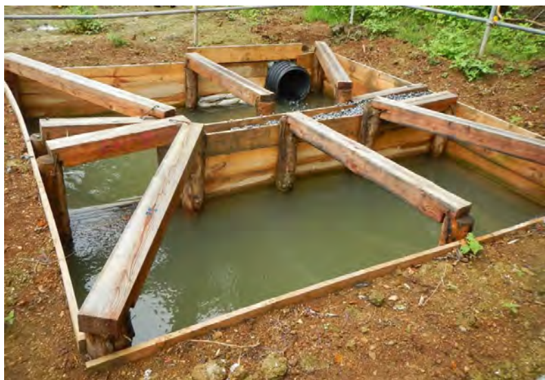
写真 3-6 仮設調整池(仮設沈砂池)の設置
