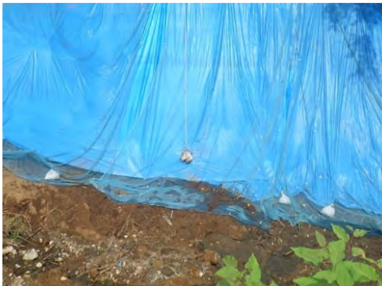
写真 1-5 養生シートの設置
