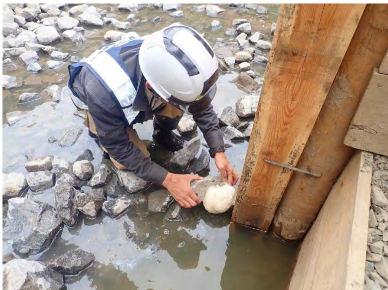
写真 7-7 施工中に新たに確認された保全対象種の移動保全状況
