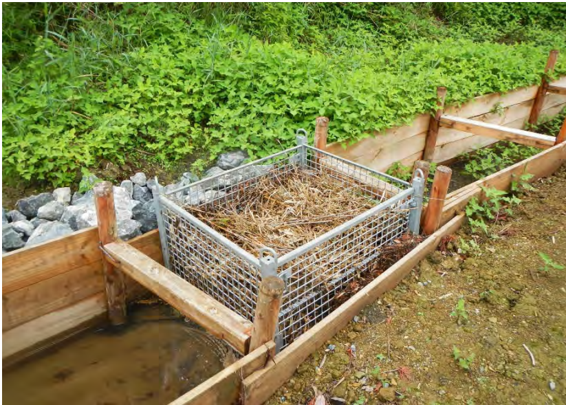
写真 4-2 伐採樹木の一部使用（濁水ろ過フィルターに利用）
