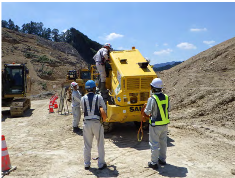
写真 5-6 建設機械の点検・整備
