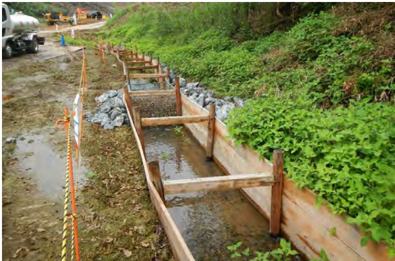
写真 3-5 工専用排水路の設置
