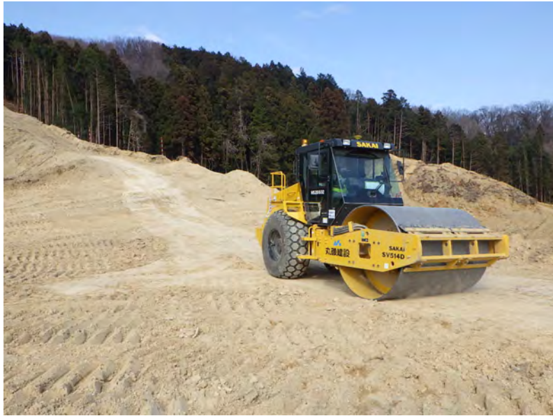
写真 3-4 造成法面の転圧
