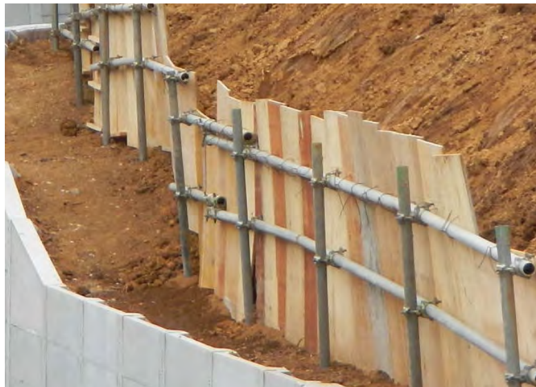
写真 1-3 土砂流出防止柵の設置
