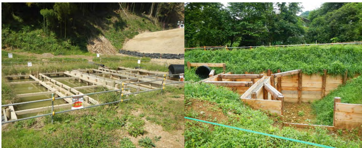
写真 1-1 仮設調整池②（仮設沈砂池）
